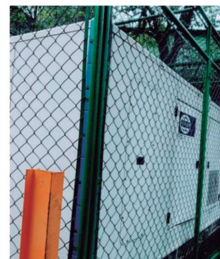
Un générateur de 625 KV alimente toute l'usine en cas de coupure de courant.
